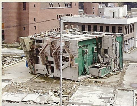
津波によって倒壊したビル
