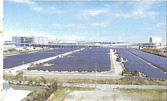
11月25日 川崎市 メガソーラー (太陽光発電施設)
