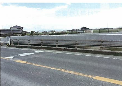
国道34号姉川橋
