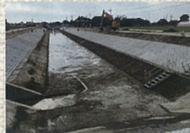
2月1日 クリーク防災工事(千代田町)
